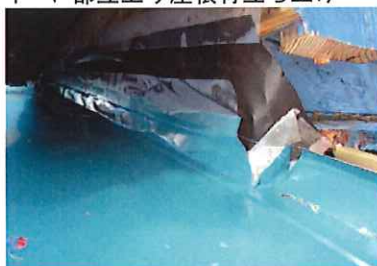
ドマー部立上り屋根材立ち上げ
