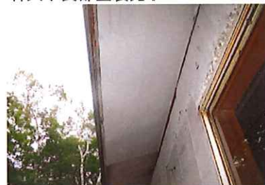
軒天不良部塗装完了
