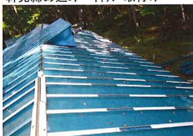
軒先締め込み・キャップ取付け
