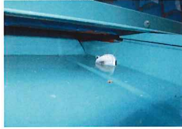
水切り下屋根材立ち上げ
