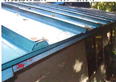
軒先締め込み・キャップ取付け
