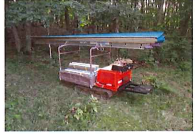
屋根材搬入 (運搬機)
