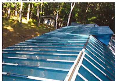
棟部屋根材立ち上げ
