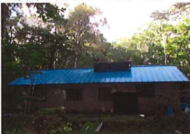
屋根葺き替えカバー工法工事完了
