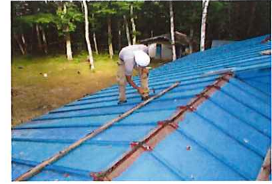
既存棟役物取外し作業状況
