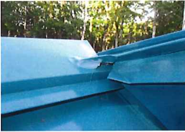
トマ-棟板金取り合い部
